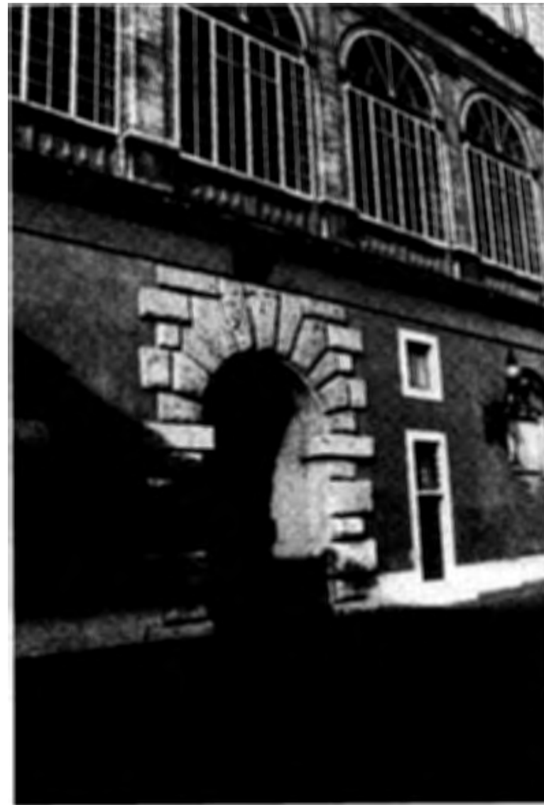
Il lato Sud Ovest del Cortile di San Damaso del Palazzo Apostolico Vaticano.
